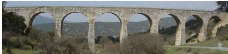
γέφυρα ανοίγματος 116,00m και ύψους 20,00m
